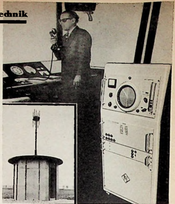
Das Innere der Peilstelle auf dem Flughafen München-Riem. Rechts der Gerätesatz, links Außenansicht des Peilhauses
